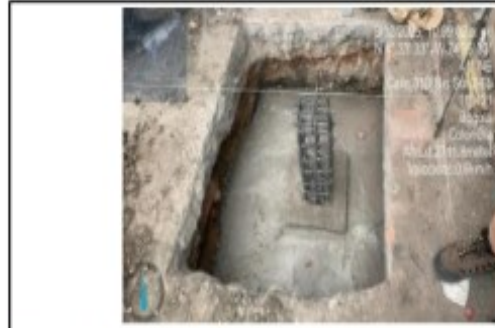
FECHA FOTO: 03/02/2025 DESCRIPCIÓN: Se realizaron actividades de fundida de zapatas y puesta de pedestales
