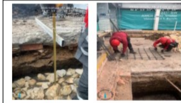
FECHA FOTO: 30/01/2025 DESCRIPCIÓN: Se realizan actividades de amarre de acero y puesta de concreto ciclopeo
