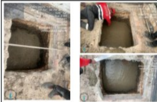
FECHA FOTO: 01/02/2025 DESCRIPCIÓN: Se realizan actividades de fundida de concreto ciclopeo para zapatas
