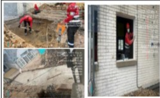
FECHA FOTO: 30/01/2025 DESCRIPCIÓN: Se realizan actividades de excavación y demolición de rampa, zapatas y pañete de perfil ventanería
